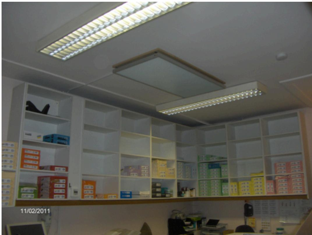
**Photo 3 : Bureau de la salle d'impression avec panneau radiant SUNNYHEAT fixé au plafond**
