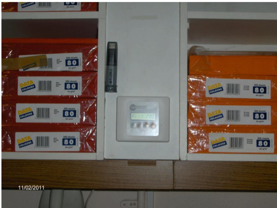
**Photo 5 : Contrôleur thermostatique sans fil et programmeur de température**
